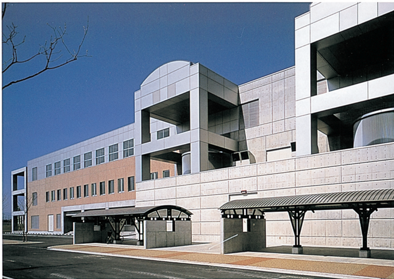
研究棟東側立面
