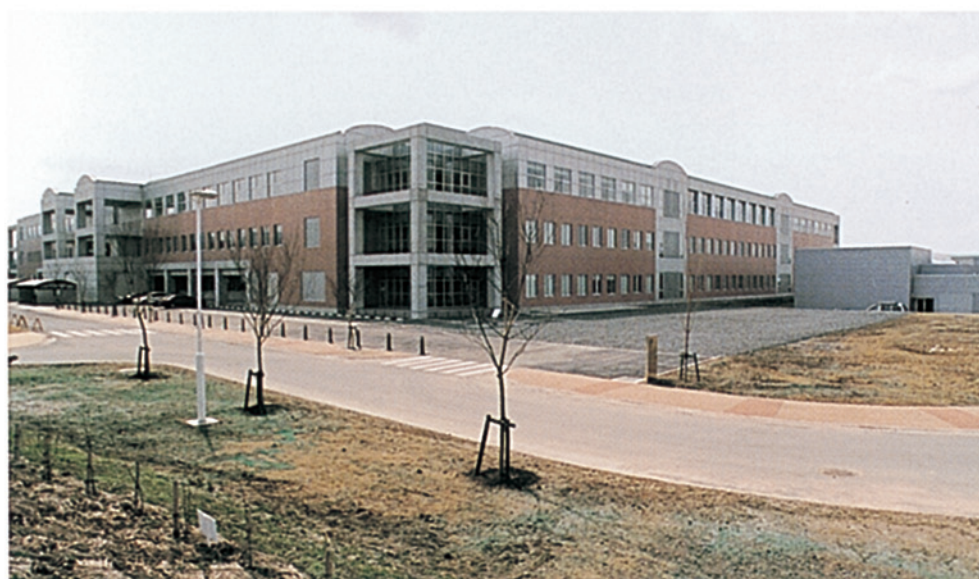
研究棟側面 (撮影方向：北東)
