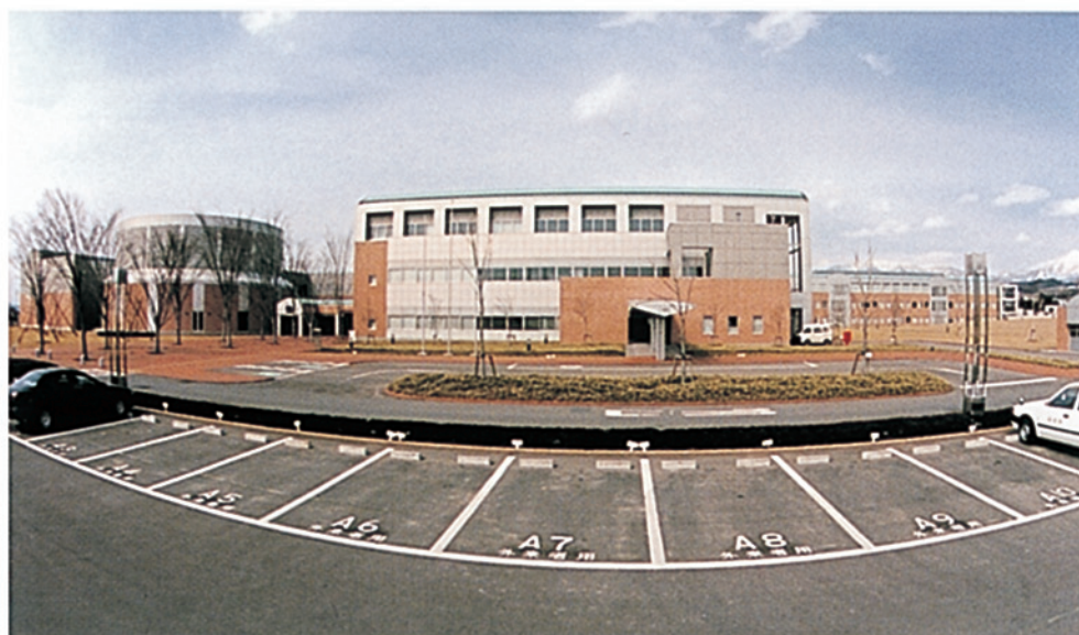
管理棟正面 左：講堂 右奥：研究棟
