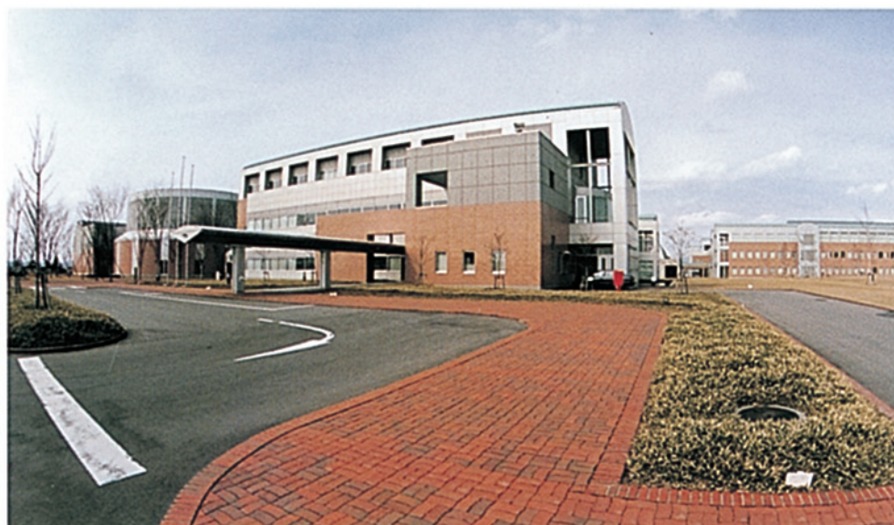
管理棟側面 左：講堂 右奥：研究棟
