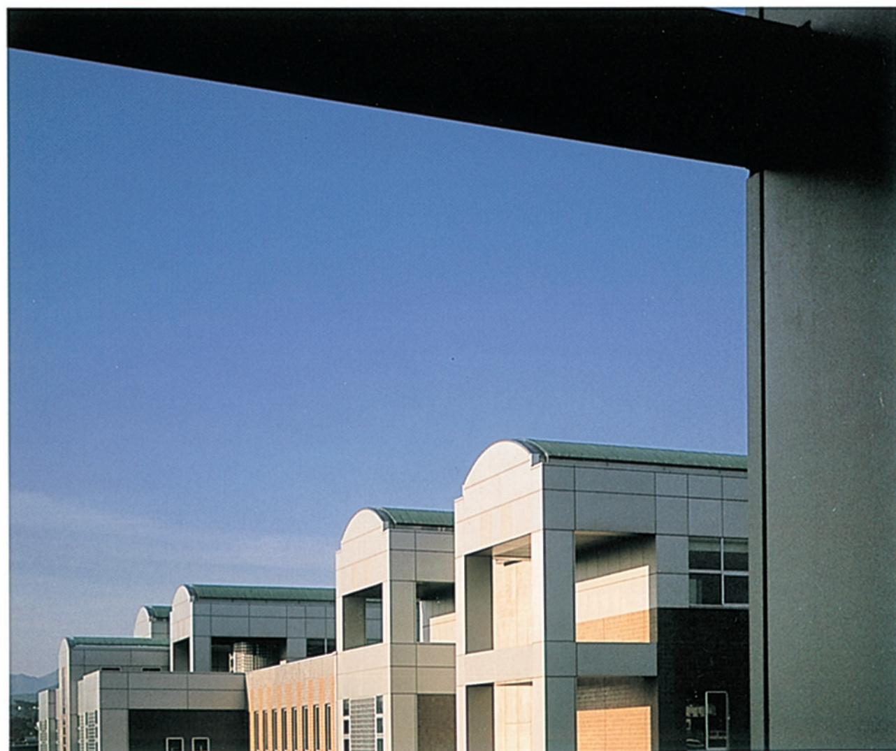
研究棟西側立面
