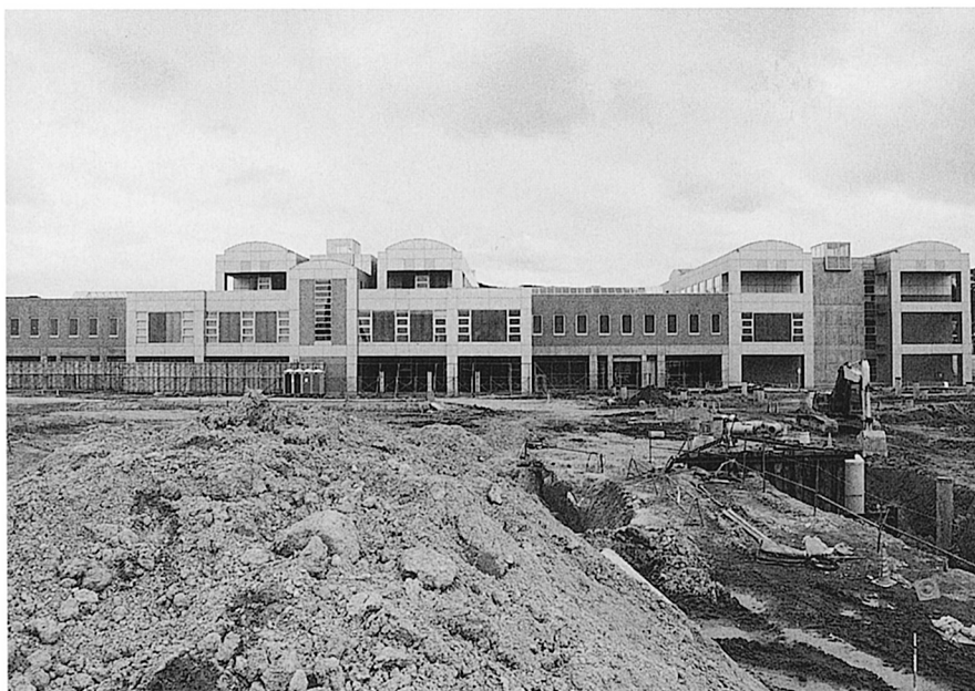
2期工事 杭地業
