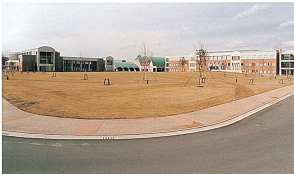
大学公園 左：管理棟 中央：体育館 右：研究棟
