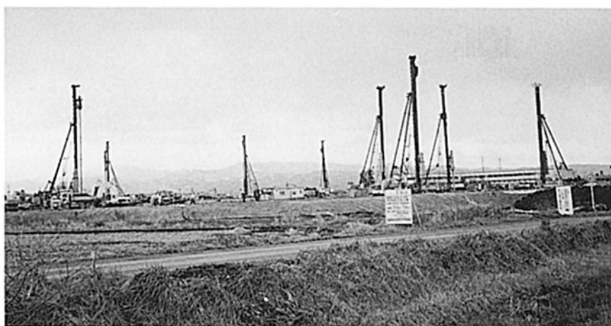
1期工事杭打（杭打機8台）
