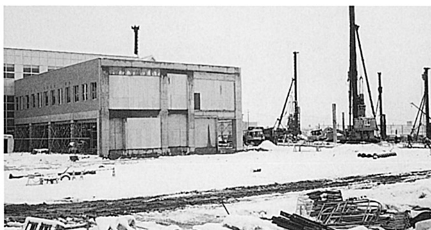
2期工事杭打（杭打機7台）
