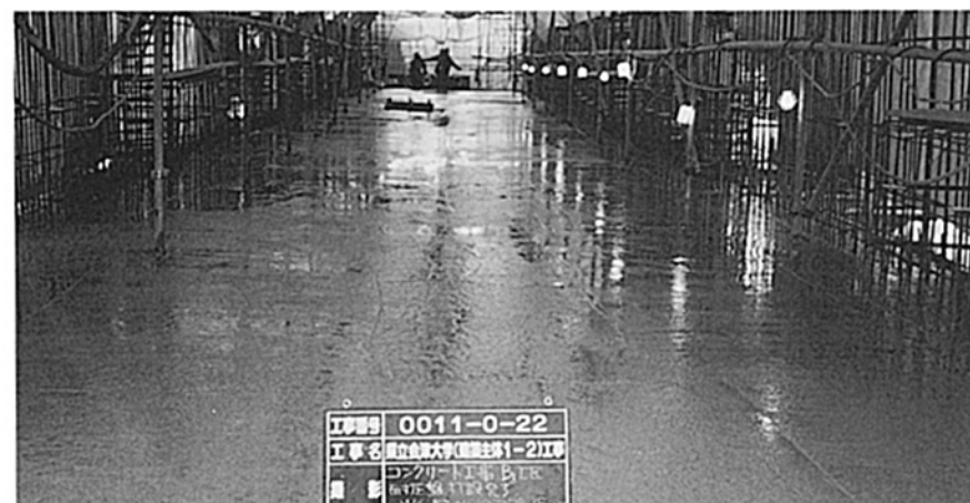
コンクリート養生
