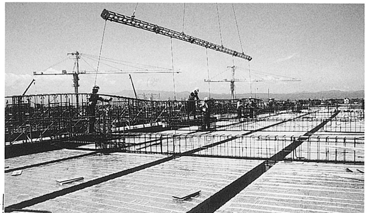
鉄筋吊り込み
