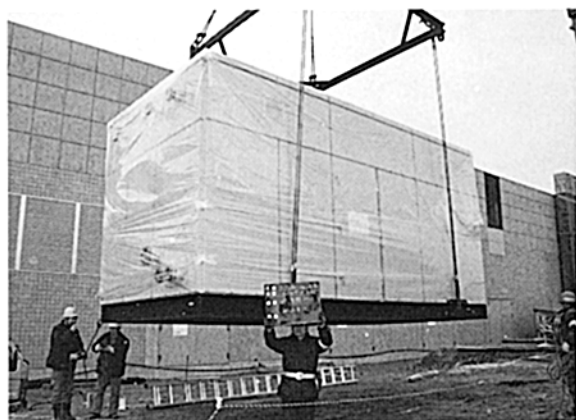
各ユニットの搬入①（クレーンにて吊り上げ）
