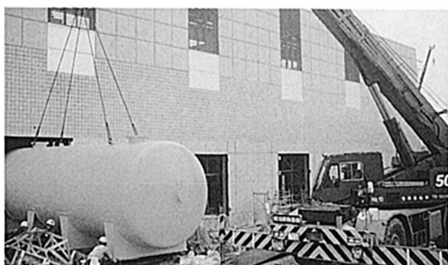
STL（潜熱蓄熱槽）搬入
