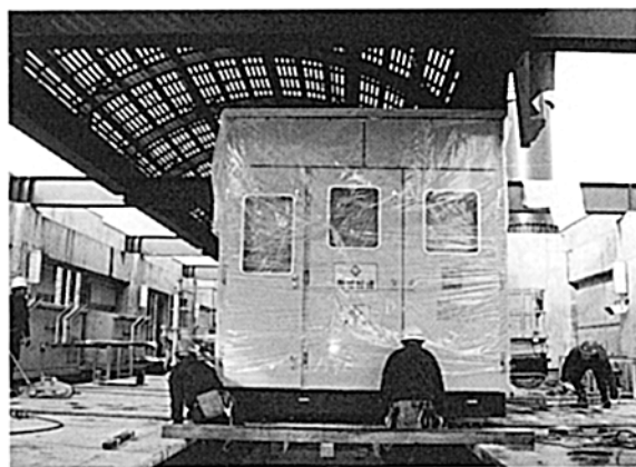
各ユニット搬入④ （移動・据付け）
