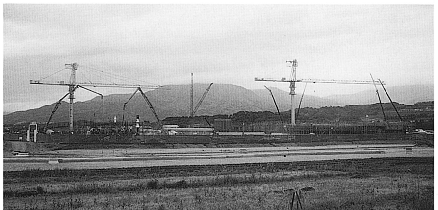
クレーン賑やかな現場
