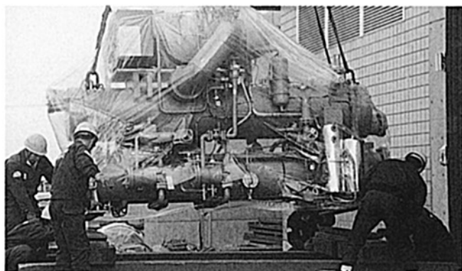
吸収式冷凍機搬入
